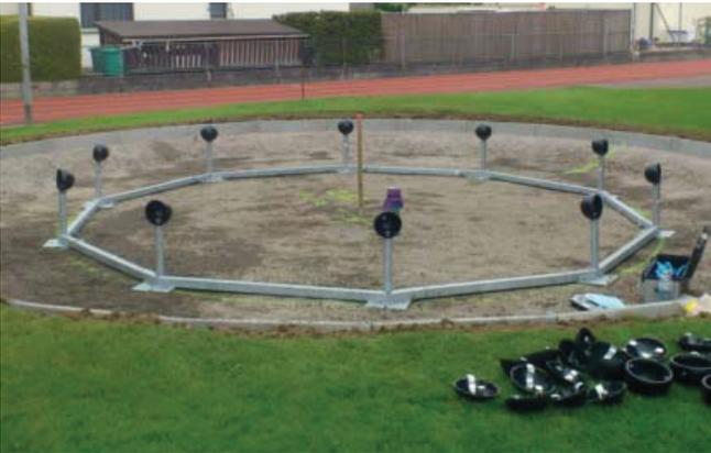
Die zertifizierten Fachwerkgeräte benötigen keine Fundamente und werden über **feuerverzinkte Ankerrahmen** montiert, die eine lange Lebensdauer und Passgenauigkeit garantieren. Fachwerkgeräte können in wenigen Stunden, mit Hilfe der mitgelieferten und bebilderten Montageanleitung, montiert werden. Anschliessend kann das Gerät zum sofortigen Spielbetrieb freigegeben werden. Dank der geringen Einbauhöhe können Fachwerkgeräte auch problemlos auf Einstellhallen aufgestellt werden.
